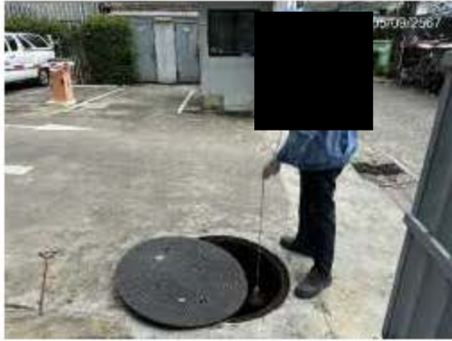
บ่อบำบัดน้ำเสียก่อนปล่อยออกนอกโครงการ ภาพที่ 3.5.3-1 จุดเก็บน้ำทิ้งบ่อบำบัดน้ำเสีย
